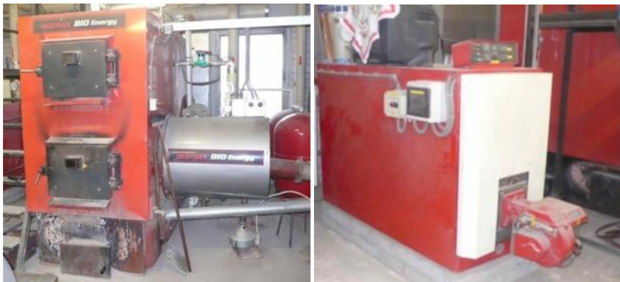
Joonis 9 Arimax Bioenergy katel (vasakul) ja Viadrus G300 katel (paremal, fotod: Ü. Kask)
