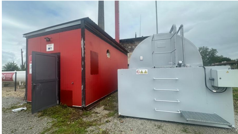
Joonis 3. Triigi küla konteinerkatlamaja (vasakul LPG mahuti ja paremal kütteõli mahuti).
